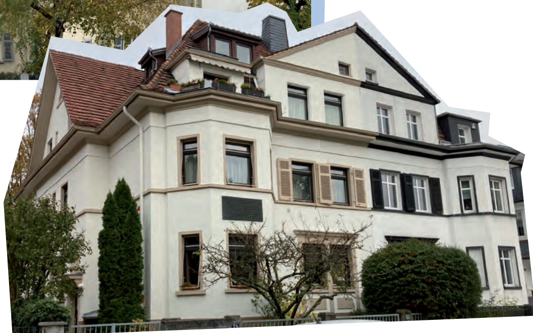
Wohnhaus in der Ganghofer Str. 24
