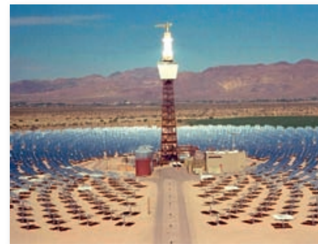
Das CSP-Versuchskraftwerk „Solar Two“ in Kalifornien ist für 10 MW ausgelegt.
