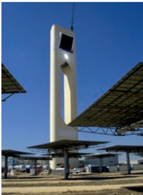
Das Solarturmkraftwerk PS10 bei Sanlucar la Mayor in Südspanien ist im Jahr 2007 ans Netz gegangen. Elektrische Leistung max. 11 MW. (DLR)
