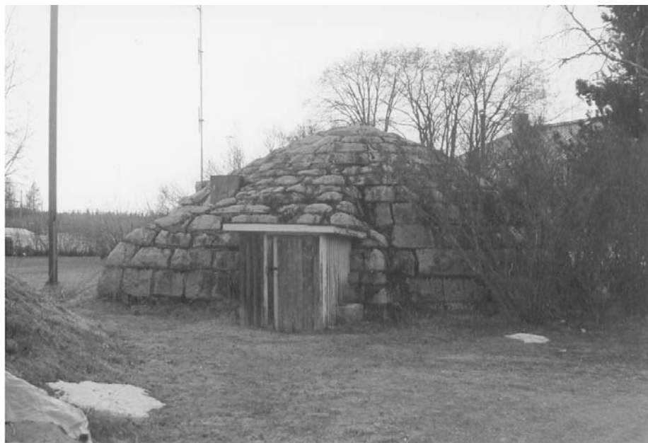
KUVA 2.30 Aseman pommisuoja, joka toimi myös ravintolan kellarina (12.05.2000)
