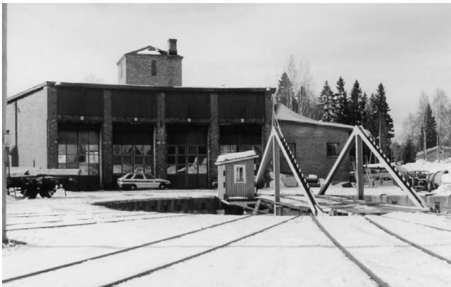
KUVA 2.22 Kontiomäen veturitallien vanha puoli ja kääntöpöytä. Tekstissä mainittu tallipäivystäjän toimisto sijaitsee tallin oikeanpuoleisessa siivessä. (Kimmo Lagerblom, 23.03.2000)
