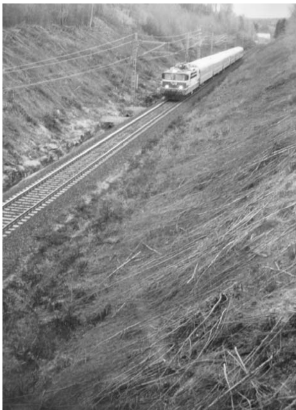
KUVA 1.6 Rautatiet muuttivat maisemaa. Leppälahden suuri leikkaus Jyväskylä — Piek-sämäki-rataosalla kuuluu yhdessä Kallaveden silta- ja pengertyömaan kanssa maamme suurimpiin käsivoimin tehtyihin maanrakennuksiin. (Kimmo Lagerblom 05.09.2002)
