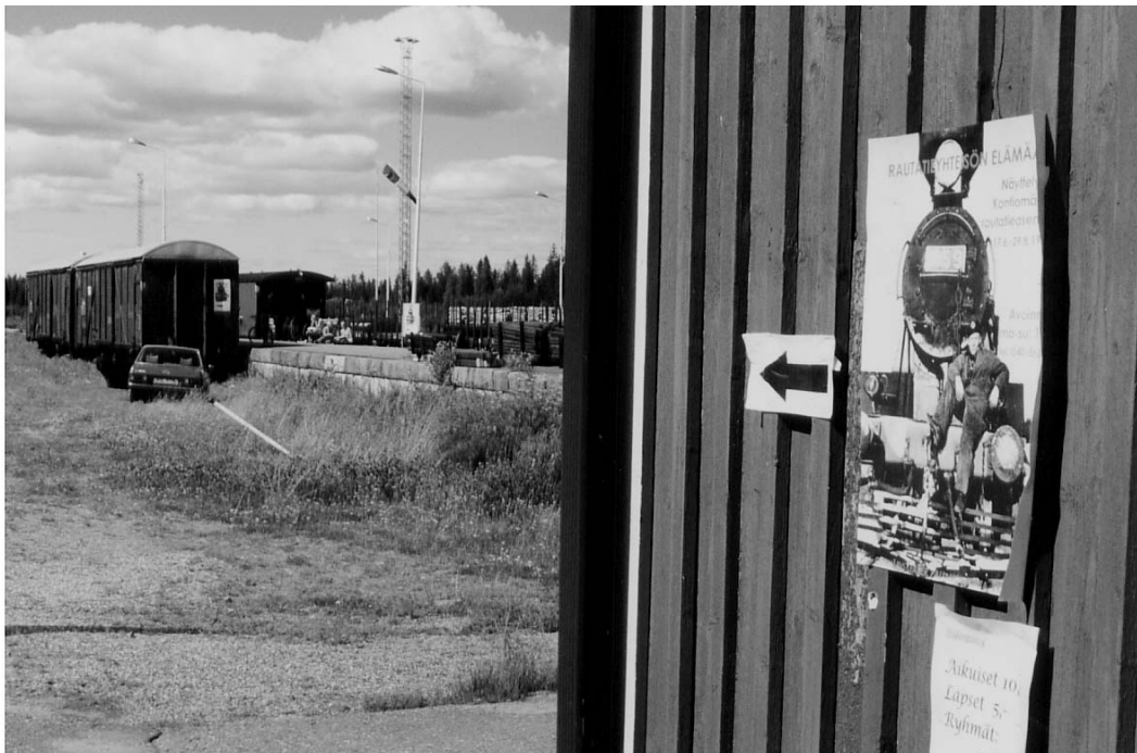
KUVA 1.1 Kesällä 1999 Kontiomäen asemalla oli esillä alueen rautatieläiselämää käsittelevä näyttely. Se oli sijoitettu tyyliin sopivasti kahteen kuvan vasemmassa laidassa näkyvään tavaravaunuun. (Kimmo Lagerblom,14.06.1999)
