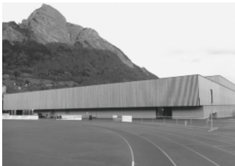
Auch die Aussenanlagen wurden neu konzipiert.
