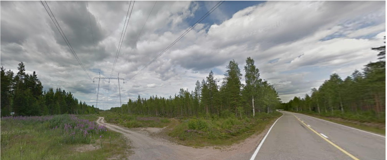
Näkymä Nummikankaantieltä (Hämeenkaan-Kyrönkankaantie, RKY) Fingridin 400 kV voimalinjalle pohjoisen suuntaan. Kuvankaappaus karttapalvelusta Google Maps. Kuvasajankohta heinäkuu 2018.
