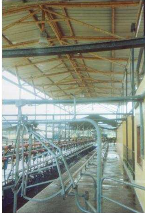
FIGURA N°07: Empleo de caña de bambú en el techo de un establo, San Rafael-Ecuador.
