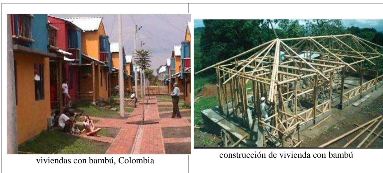
FIGURA N°05: Vivienda de interés social, en Colombia. (fotos: Alvarez-2001) 18
