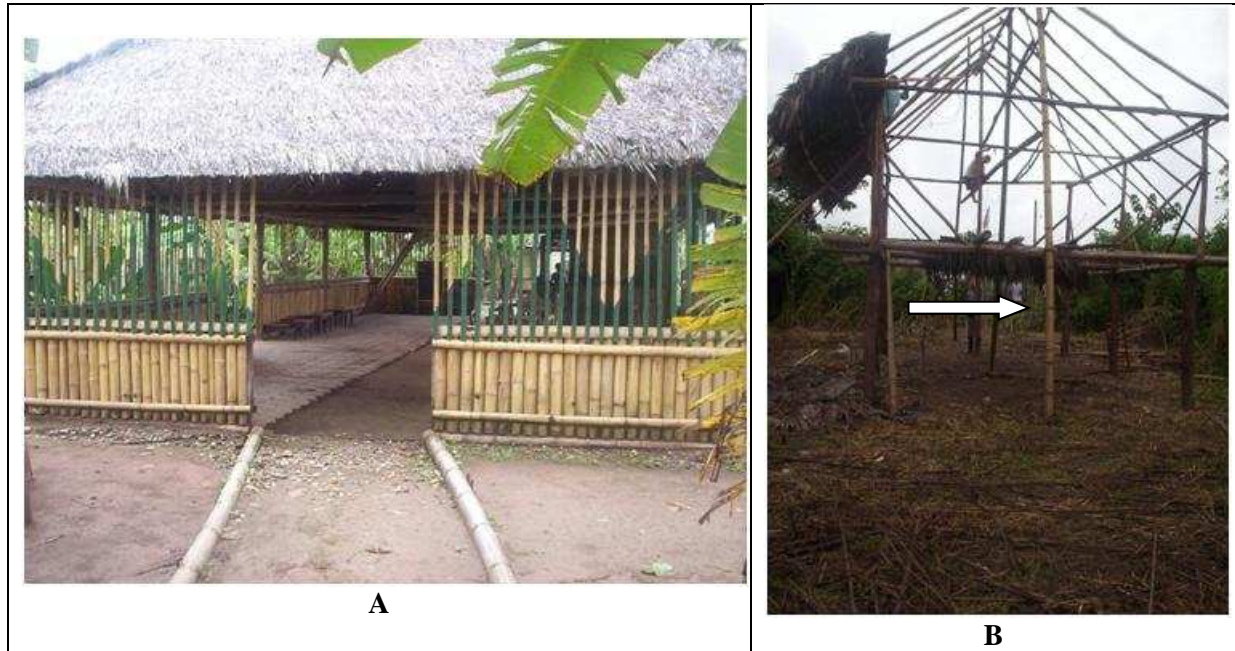
FIGURA N° 58: Usos de Dendrocalamus asper en Puerto Bermúdez: (A) en construcción de restaurante; (B) como soporte durante construcción de vivienda.
