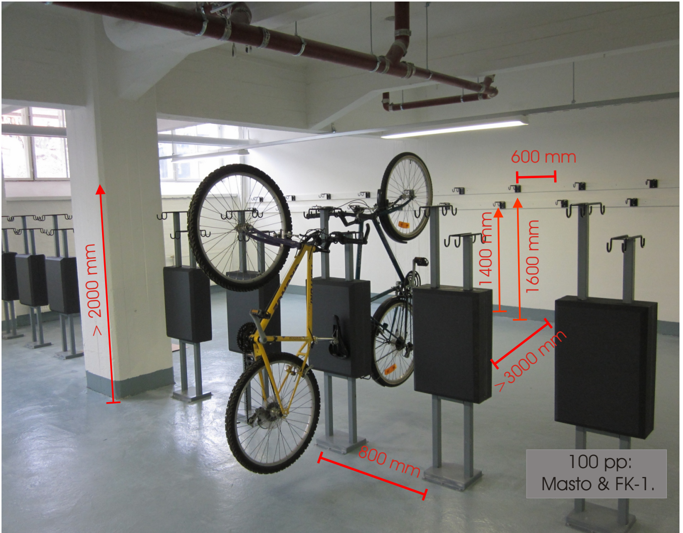
Ulkovilälinevarasto: FK-1-koukut ja Masto tilan keskellä, yhteensä noin 100 pyöräpaikkaa
