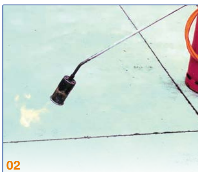
02 Beton vorwärmen, Primer vorstreichen. Primer mit Flamme aktivieren.
