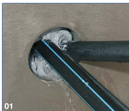
01 Einspritzen von Flex 2000 bei einströmendem Wasser.
