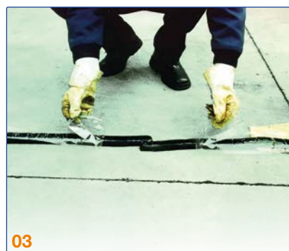
03 Papier abziehen und die Stöße seitlich zusammendrücken.
