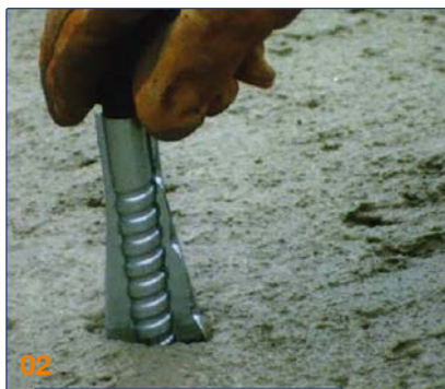
02 Einbau in Ortbeton.
