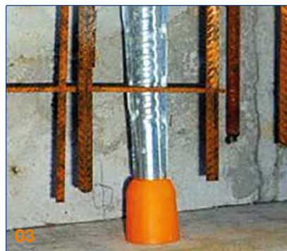
03 Vertiefter Einbau mit Schalungsstopfen Jumbo 50.
