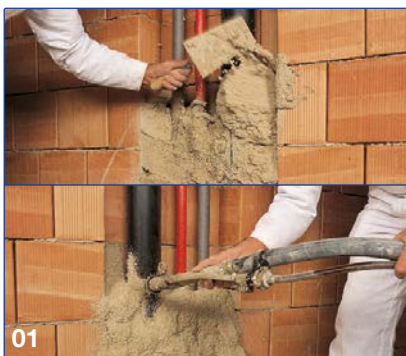
01 Anwerfen mit Kelle oder Verarbeitung mit Putzmaschine.
