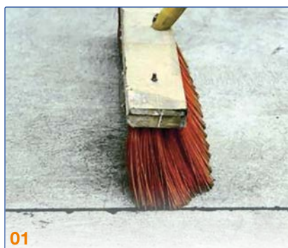
01 Fugenbereich reinigen.
