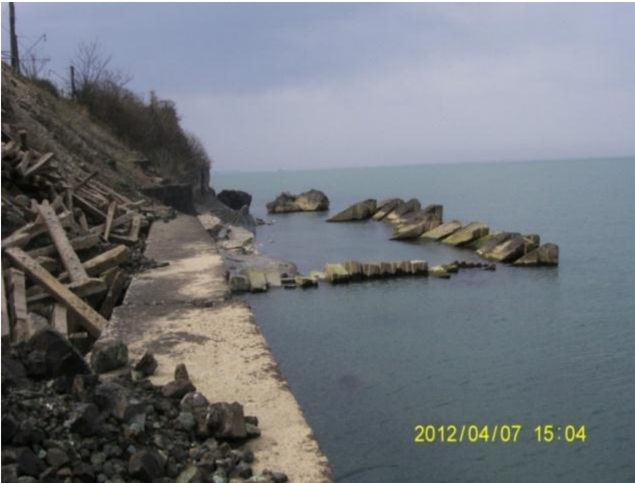
სურათი1-9. დაზიანებული ტალღამრეკლი კედელი და სამშენებლო ნარჩენები (ციხისძირი)
