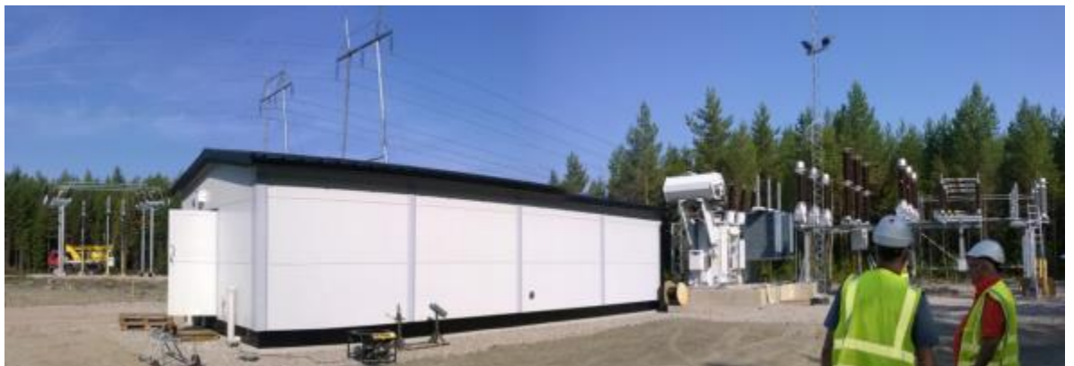
Kuva 12 Esimerkki rakenteilla olevasta tuulivoimapuiston sähköasemasta.
