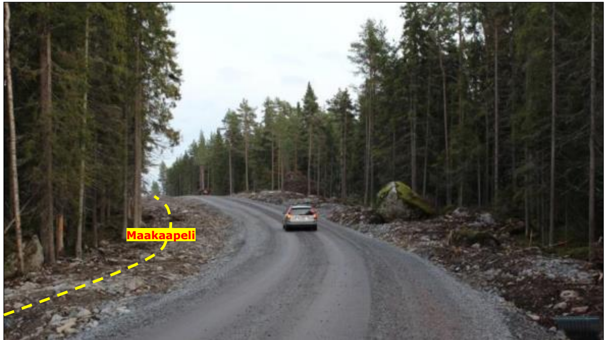
Kuva 10 . Esimerkki tuulivoimapuiston rakennus- ja huoltotiestä. Teitä käytetään muun muassa betonin ja soran sekä voimaloiden komponenttien kuljetuksiin. Tuulivoimapuiston käyttövaiheessa teitä käytetään mm. vuosittaisissa huolloissa. Maakaapelin oja on sijoitettu tien vasemmalle puolelle.
