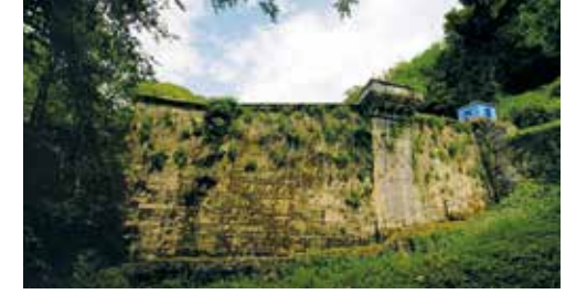
13.45 metre yüksekliğindeki Ayvad Bendi'nin mansap tarafından genel görünüşü (Foto: R. Çetiner).
