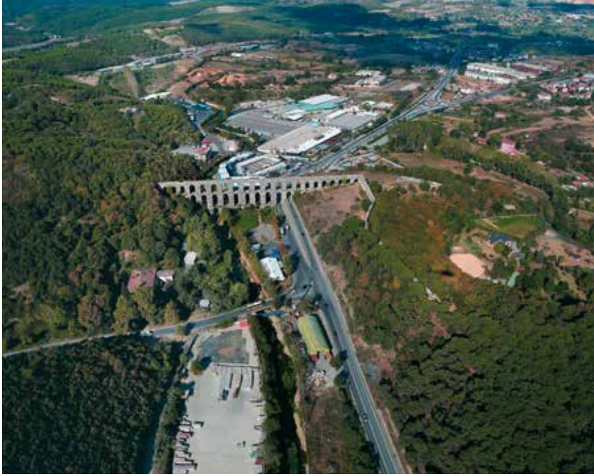
Bir zamanlar Belgrad Ormanı'nın sınırları içinde olan Kemberburgaz'daki Kırkçeşme Su Yolu'nun tek üç katlı su kemeri olan ve kendine has mimarisiyle Avrupalı seyahatçilerin ilgisini toplayan Kovuk (Eğri) Kemer, günümüzde etrafını saran tesisler ve kentleşme baskısının arasında sıkışıp kalmış durumdadır (Foto: R. Çetiner).
