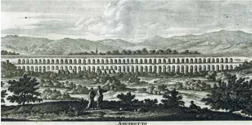
Mimar Sinan tarafından inşa edilen 2 katlı ve 711 metre uzunluğundaki Uzun Kemer'in Cornelis de Bruyn'a ait gravürü (Galeri Alfa, Ayşe Yetişkin Kubilay'ın izniyle).
