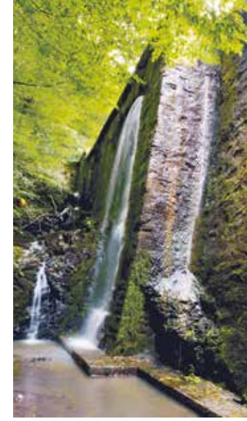
Karanlık Bend'in (Kömürçü Bendi) payandalarla desteklenmiş olan duvarı (Foto: R. Çetiner).
