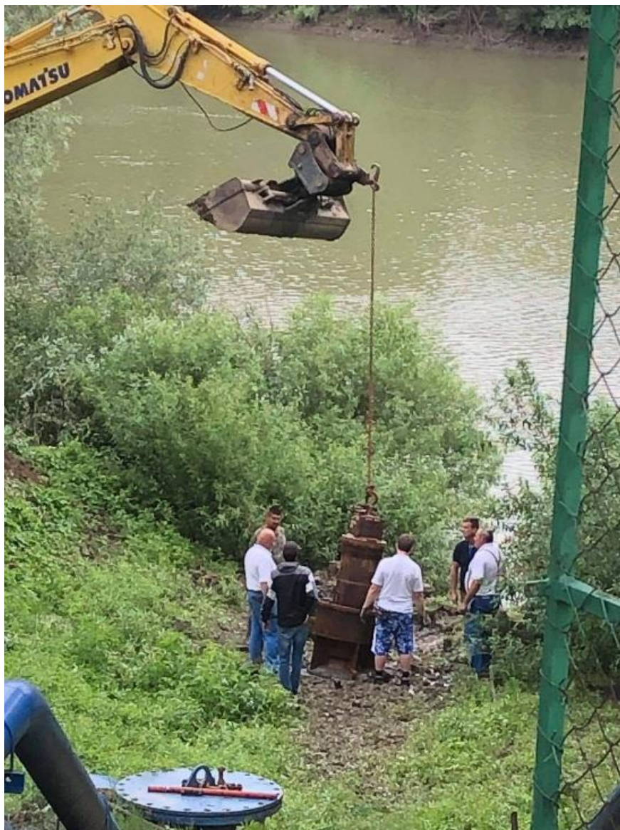
41. kép FLYGT szivattyú beemelése
