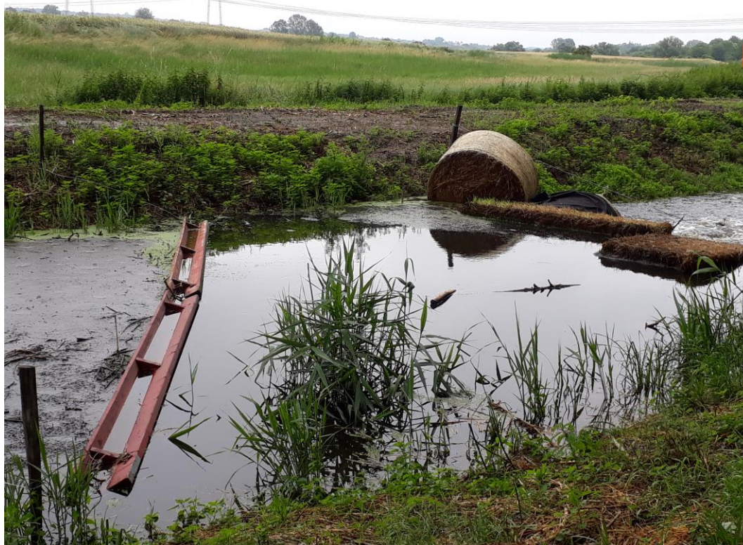
1. kép Terelőfalas, szalmabálás elzárás
