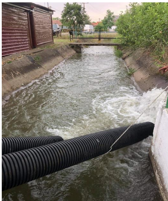
40. kép Az öntözőcsatorna feltöltése nyomócsőág kiépítésével
