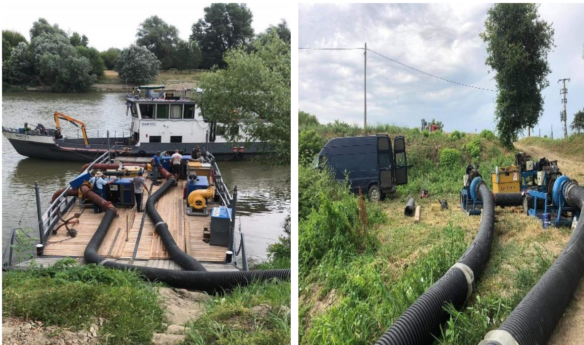
39. kép Úszóművel történő felvonulás, nyomócsőág kiépítése
