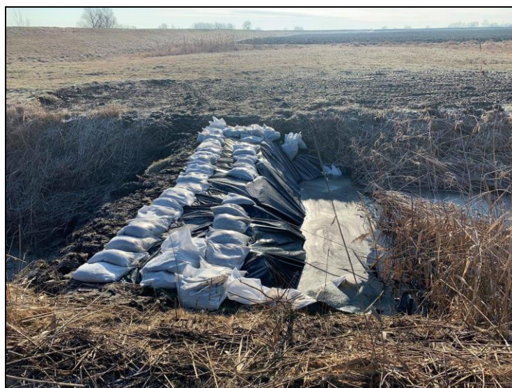
42. kép Üzemi csatorna ideiglenes zárása
