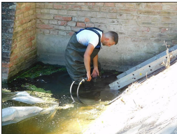
27. kép Injektálás közben
