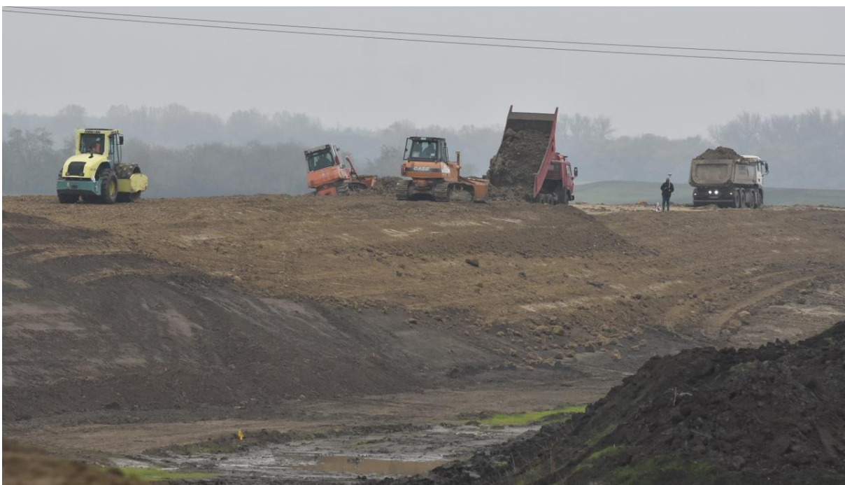
60. kép Töltésépítés Fokorú-pusztán
