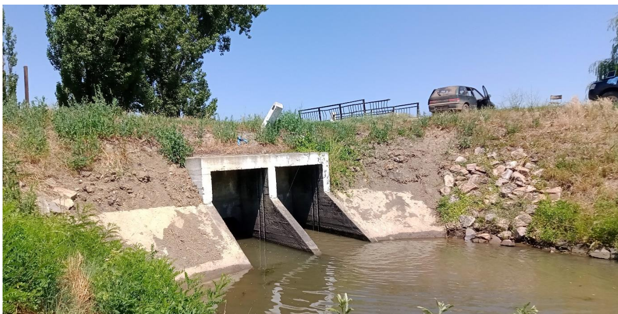
2. kép NK-III-2-4 öntözőcsatorna 4+250 km szelvényben található műtárgy.
