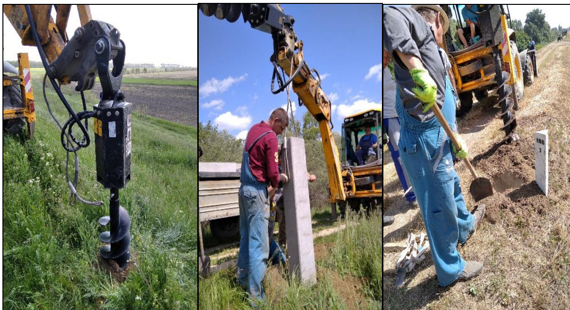
24. kép Töltéstartozékok cseréje a 10.04-es és 10.07-es árvízvédelmi szakaszokon
