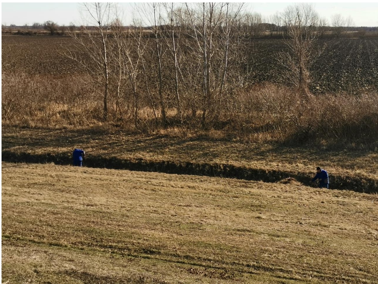
50. kép Szivárgó csatorna karbantartása
