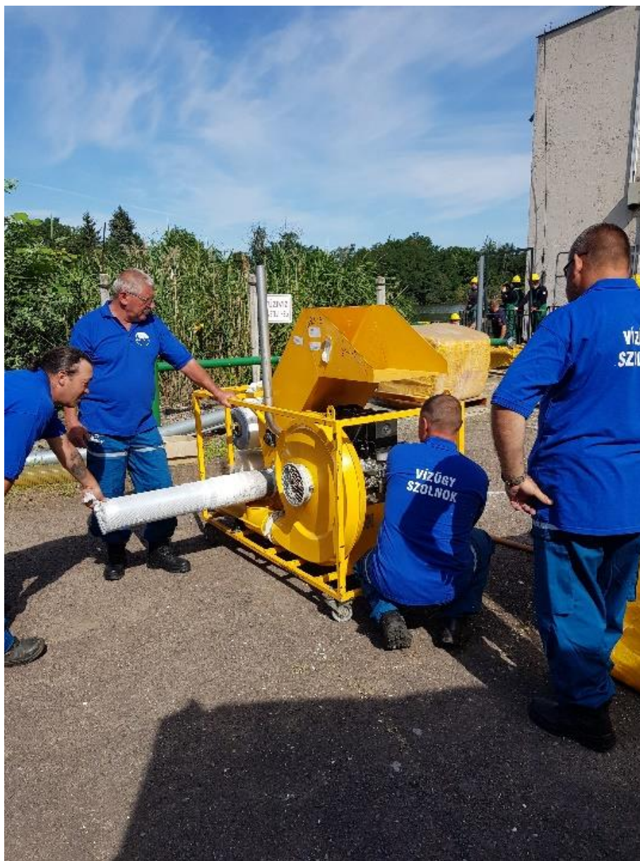
32. kép SANOL hurka töltése
