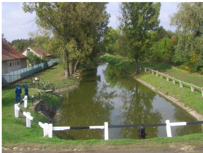
2. kép Karcagi I. csatorna
