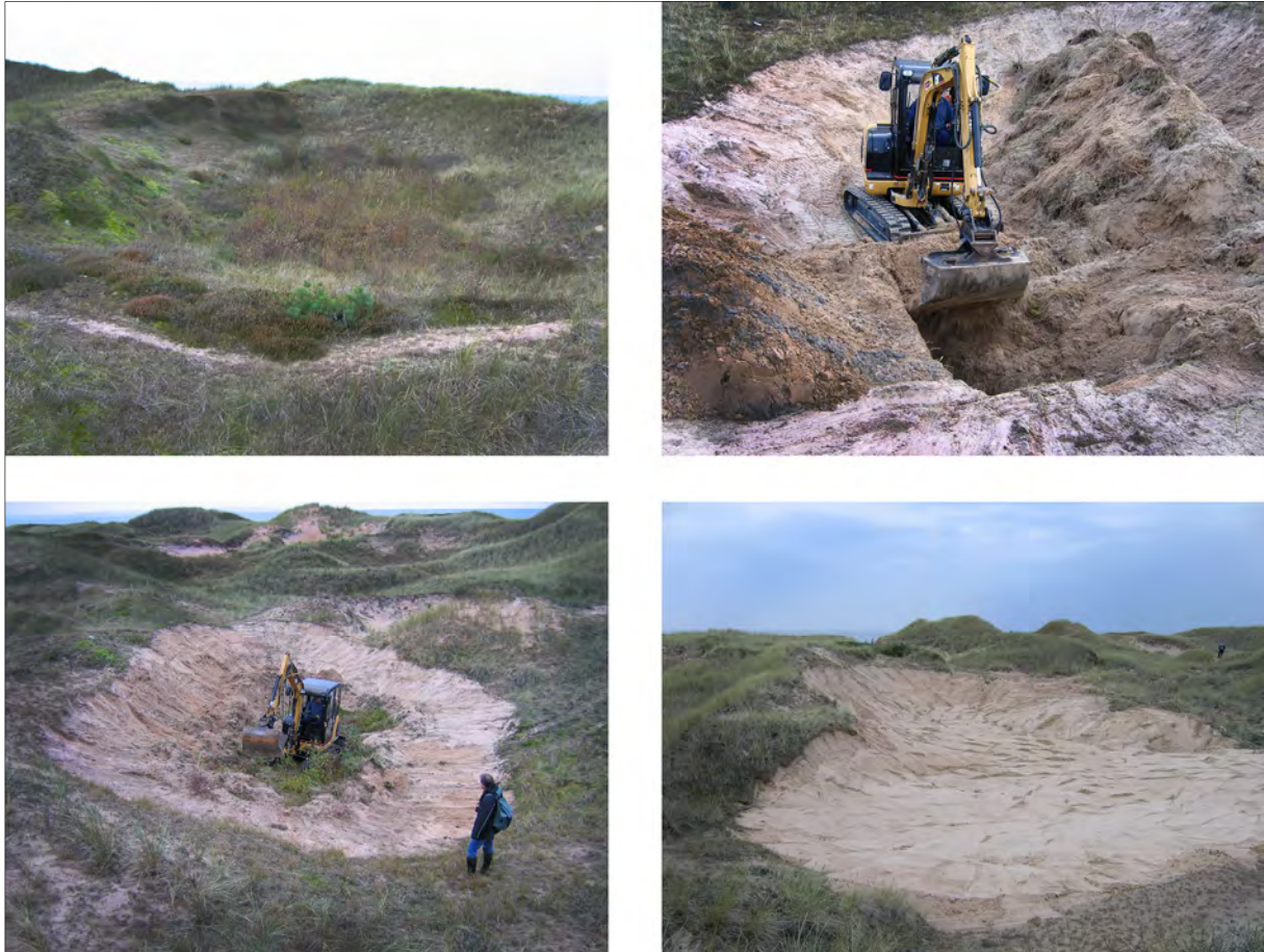
Sandblottan växer fram i dynsvackan, från början till slut i fyra steg. Skapas några liknande sandblottor på vintersäsong med några års mellanrum finns hela tiden bar sand i olika successionsstadier tillgängliga. Foto: Kill Persson.
