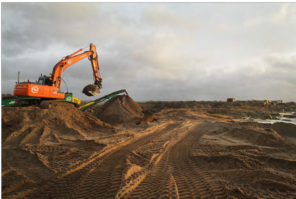
Nya dynstrukturer växer fram i Skreanäs med sanden från sorterverk (bakgrunden) och grävare med planerskopa i förgrunden, december 2011, Falkenbergs kn. Foto: Kill Persson.
