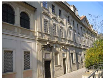
Abb. 4: Reich geschmückte Fassade des Krankenhauses der Barmherzigen Brüder.
