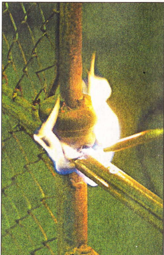
Auch Schweißarbeiten sind am Pavillon nötig.
