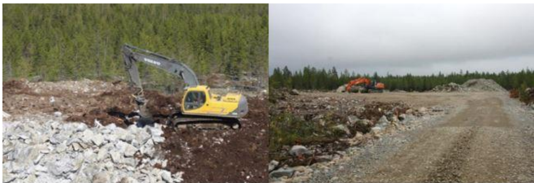
Kuva 9.9. Tuulivoimapuiston rakentaminen alkaa huoltoteiden ja pystytysalueiden rakentamisella (Ville Suorsa, FCG).
