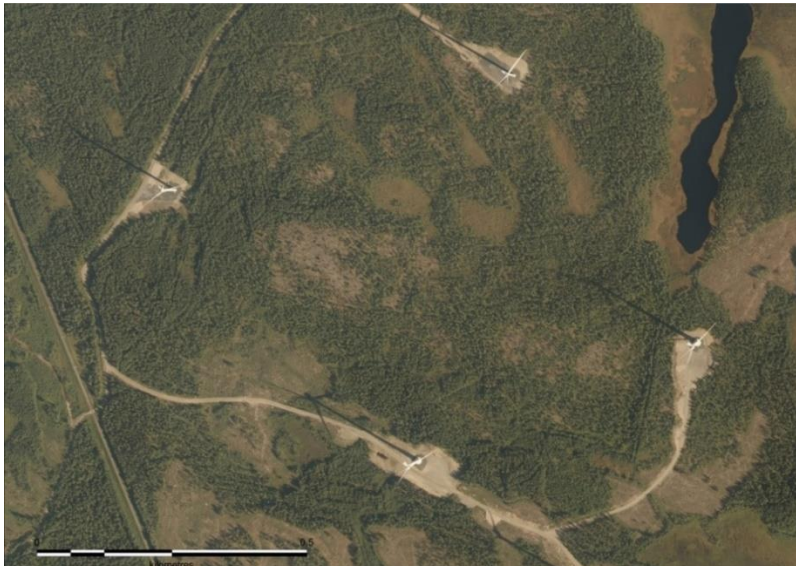
Kuva 9.1. Ilmakuvassa näkyy toiminnassa olevia tuulivoimaloita. Tuulivoimaloita varten on rakennettu huoltotiet ja nostokentät. Tuulivoimaloiden ympäristössä ja välialueilla aikaisempi maankäyttö on säilynyt ennallaan (Maanmittauslaitos). Kuva ei ole Lylyharjun alueelta.
