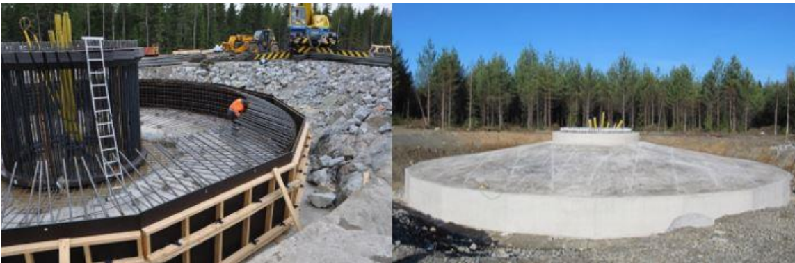
Kuva 9.11. Tuulivoimalan perustusten rakentamista (Leila Väyrynen, FCG).
