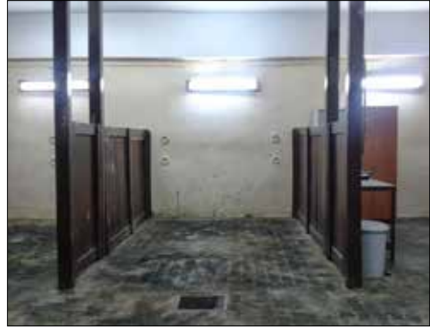
Resim 141. Nal çakma bölümü
