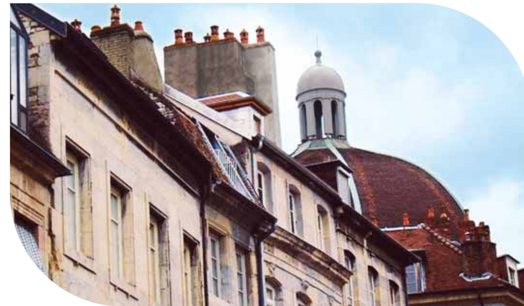
Intégration des antennes dans l'environnement, comme ici dans le clocheton du toit
