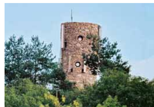
Pour préserver l'environnement visuel, des solutions de camouflage des antennes sont mises en œuvre.
