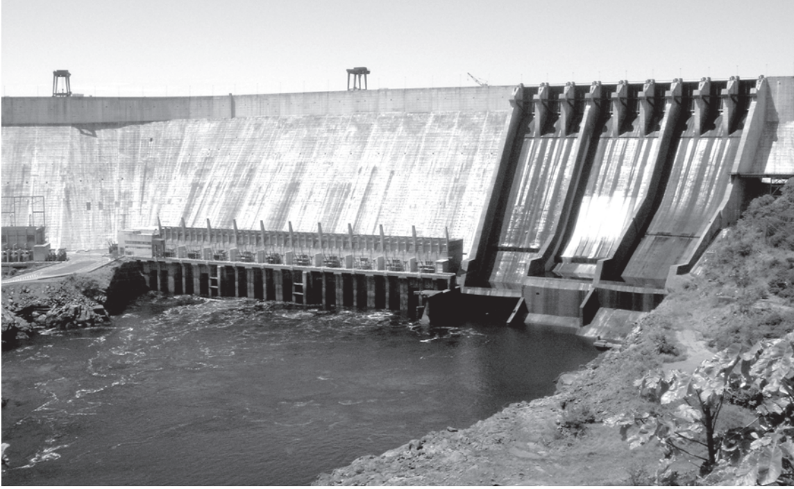
▲ Das Kraftwerk Guri-Simón Bolívar Ein Großteil der in Venezuela verbrauchten Energie wird hier produziert
