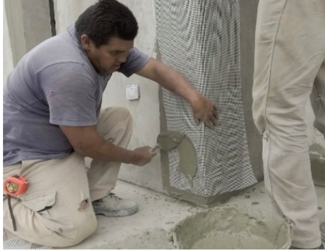
Aplicación de basecoat sobre revoque termoaislante.
