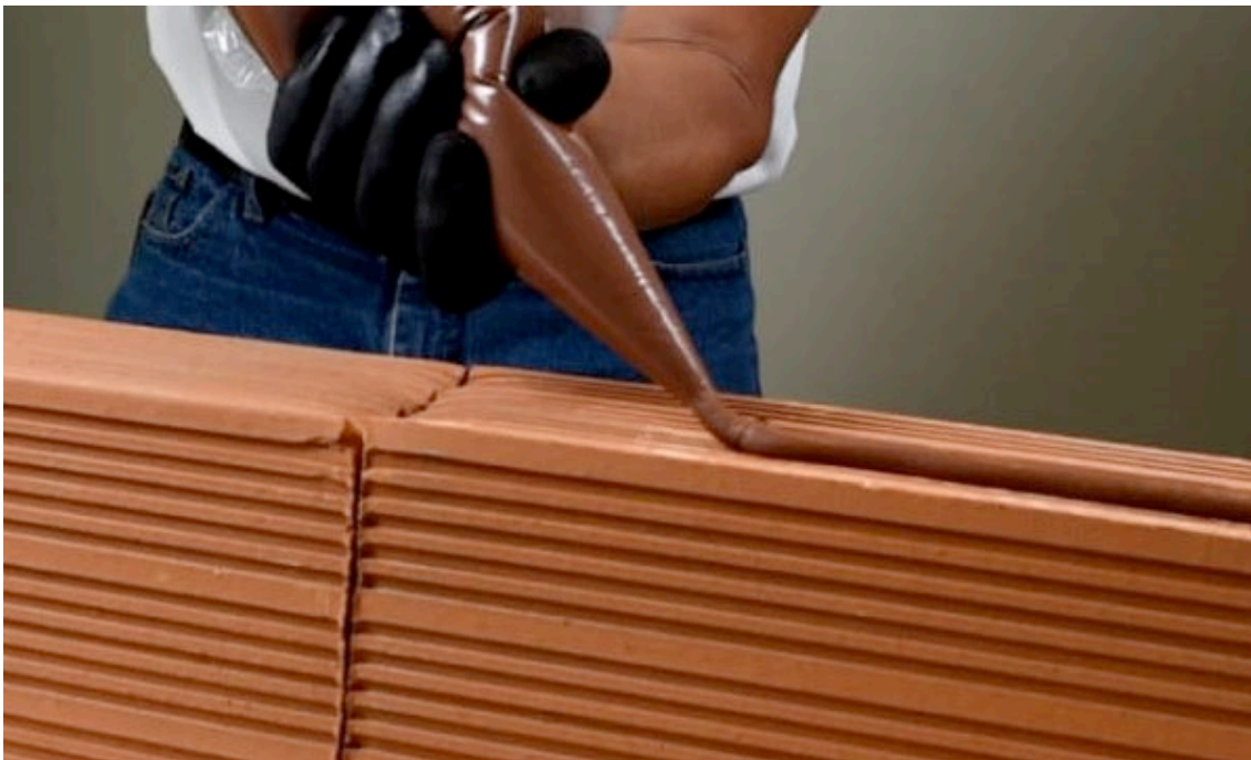
Aplicación de mortero en manga.
