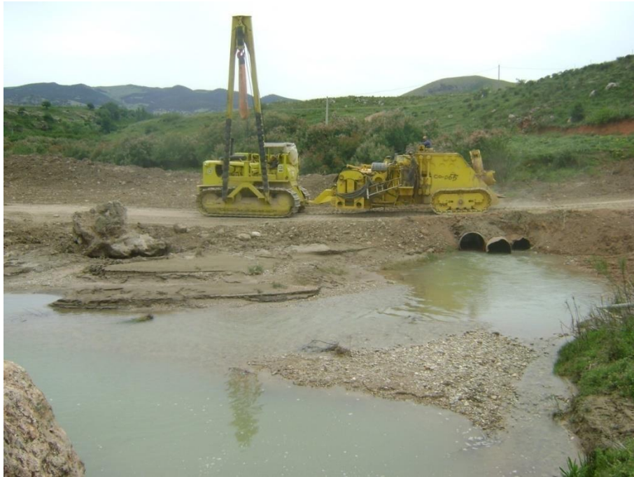
Figure 2.3. Construction de route à Ain Makhoul en 2010 où une population de Calotperyx exul existe.
