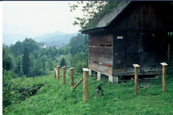
Ein gut gewarteter Elektrozaun kann eine Bienenhütte effizient vor Besuchen eines Bären schützen.
