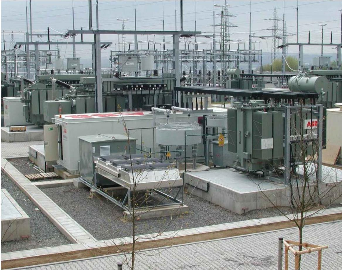
**ABB 15-MW-Standardumrichter – 8 Units**
