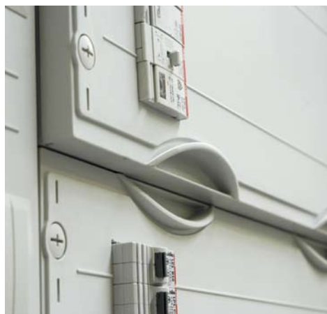
Vertikale Geräteanordnung
