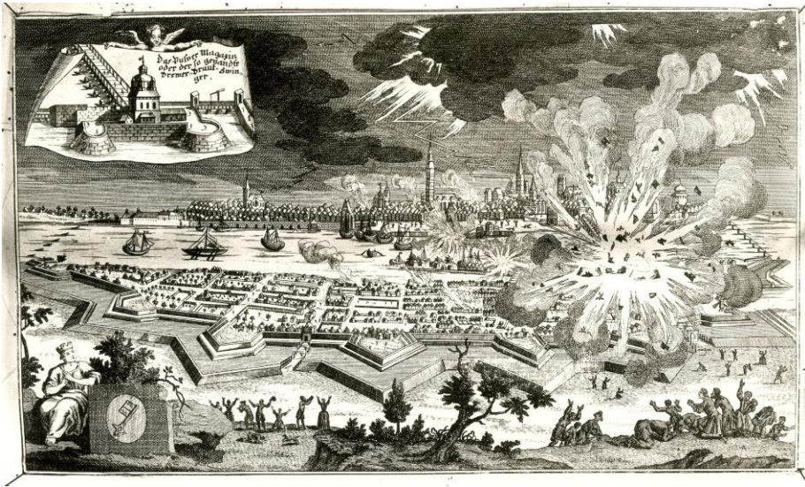
Abb. 2 Explosion des Kastells „Braut“, Kupferstich 1739 84
