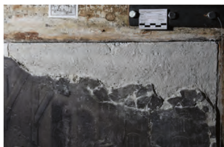
18 Mit einem feinen, dem originalen Malereiputz angeglichenen Mörtel wurde der Deckputz ergänzt.
