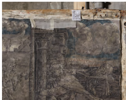
14 Gefach mit den Szenen Pfarrer (21) und Bettelmönch (22). Im rechten Bildteil wurden die hellen, auffallenden Fehlstellen retuschiert, um ein geschlossenes Gesamterscheinungsbild und eine Verbesserung der Lesbarkeit zu erreichen.
