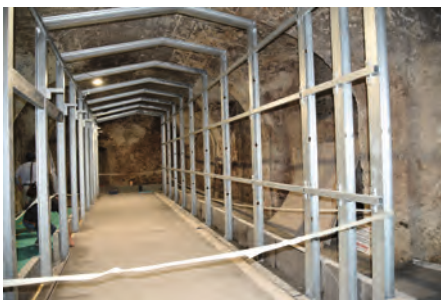
21 Die metallene Grundkonstruktion für die Befestigung der Ausfachungen.
