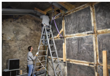
22 Die Montage des obersten Registers erwies sich als besondere Herausforderung.
