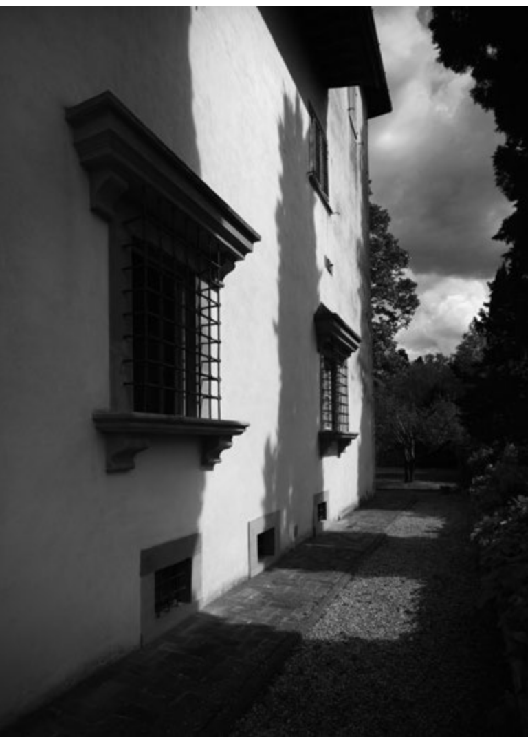
Fig. 4. La facciata sud della villa (sinistra). A destra dettaglio delle finestre inginocchiate con davanzale sporgente su mensole piegate a guisa di ginocchio.
