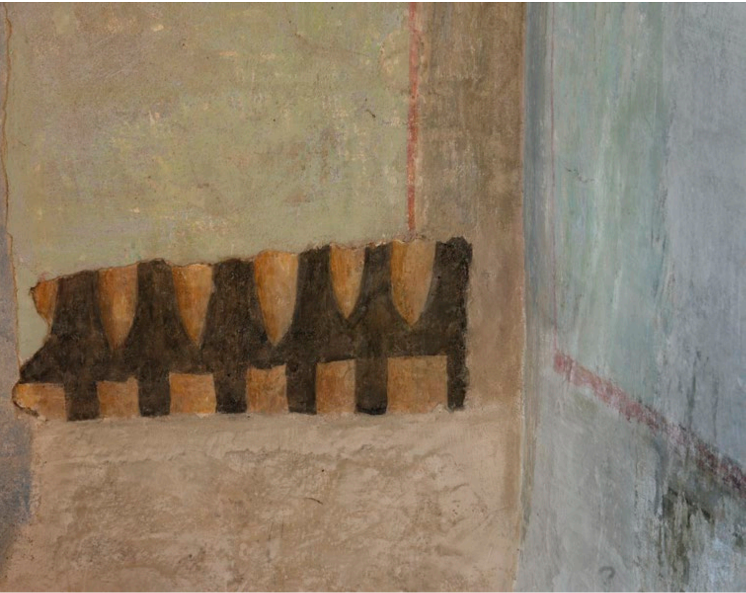
Fig. 28. Residui (50 cm) della decorazione trecentesca ritrovata , durante i restauri, nella stanza da letto di Galileo ('seconda camera'). Già nel XVII secolo la decorazione era ricoperta da tinteggiatura più moderna come si vede sulla parete di destra.
