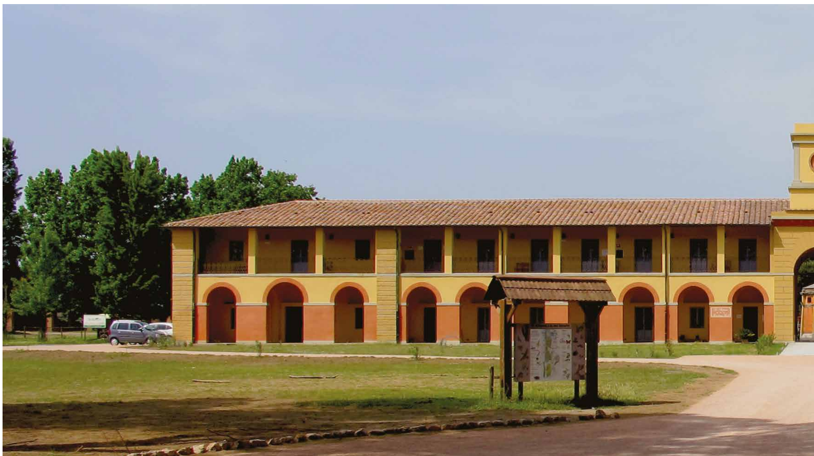
Fig. 13 - Fronte principale del complesso di Sterpaia
