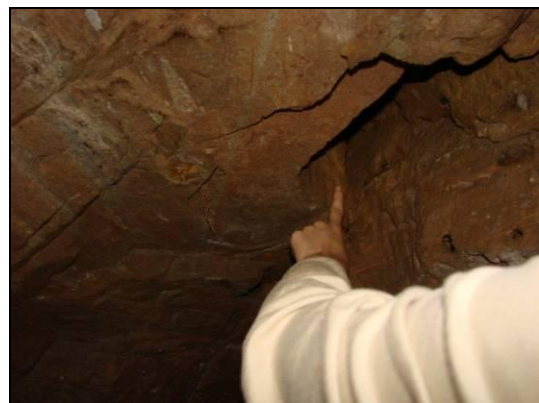
Foto 3.28 - Feição de dissolução denominada Solution Pocket , no teto da cavidade
