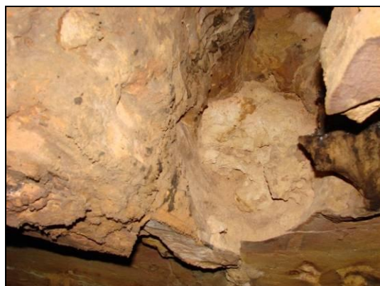
Foto 3.32 - Fratura no teto da caverna preenchida por material de alteração da rocha
