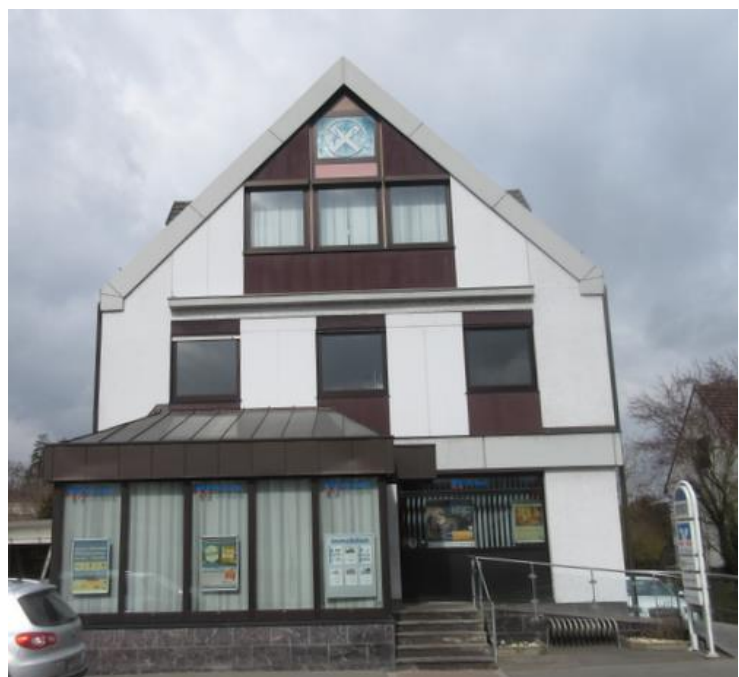
Die Zentrale der Raiffeisenbank Werneck in der Balthasar-Neumann-Str. 15
