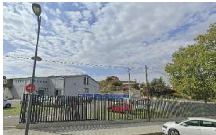
Exterior del pavelló 2 de Sant Fost. Foto: Arxiu
