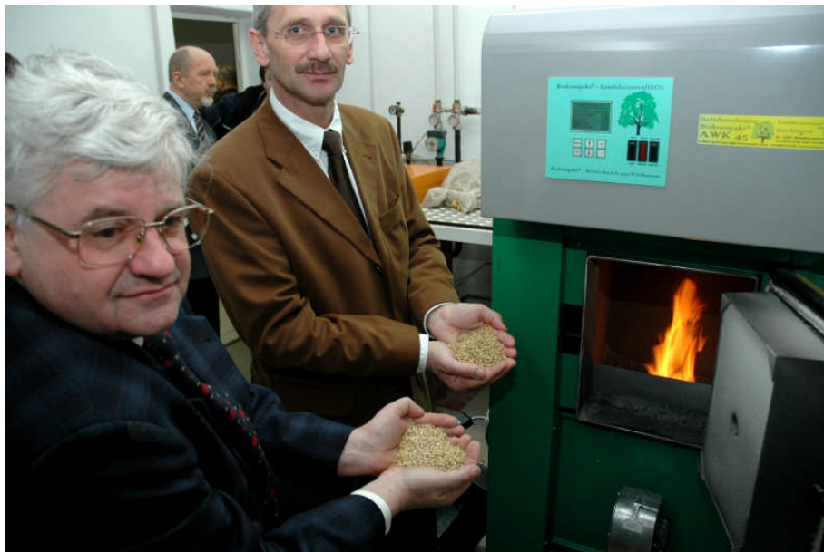
Abb. 8: Inbetriebnahme des Biokompaktkessels am 11.02.2005 (mit Herrn Gerlinger und Herrn Schulenburg im Vordergrund)
