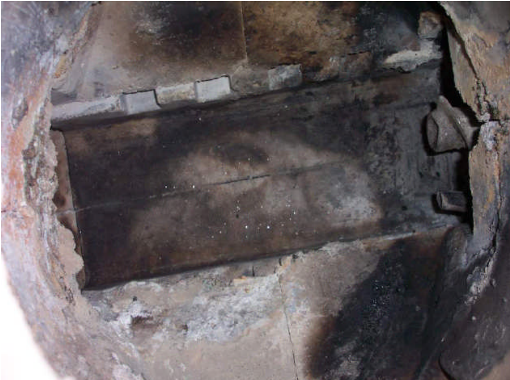
Abb. 50: Blick von oben in die Brennraumschale mit Primärluftschlitzen, Zuführschnecke und Heißluftzündrohr
