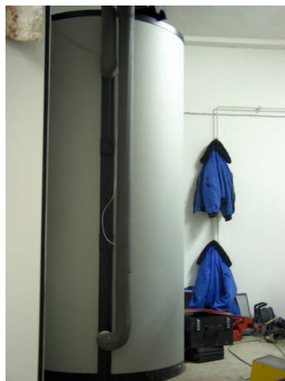
Abb. 2: Schichtenspeicher (145 l Wassereinhalten)
