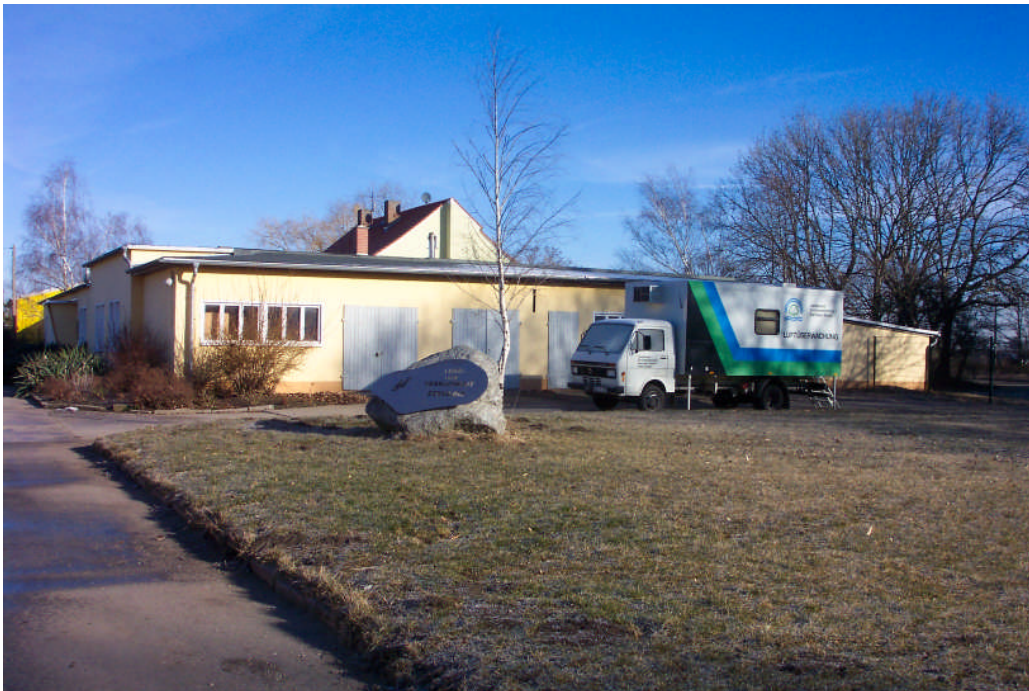
Abb. 1: Außenansicht des Kesselstandortes (mit Messwagen im Vordergrund)
