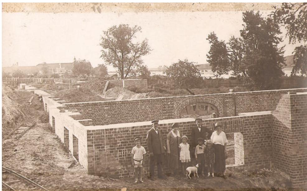
Początek budowy szkoły
