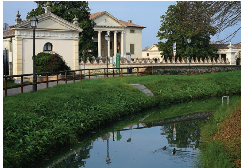
Fratta Polesine, il ponte sullo Scortico davanti alla villa Badoer detta la Badoera
