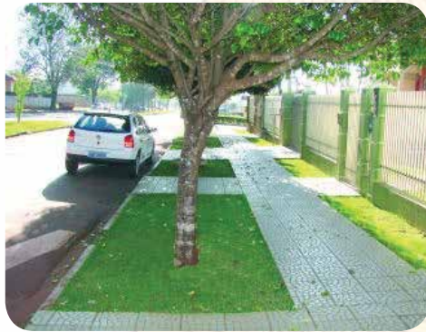
Foto 18: Exemplo de readequação de canteiro, criando calçada ecológica
