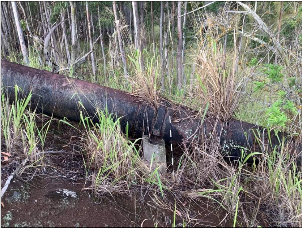
Figure 78. Site 7346 Feature 160-A siphon invert.
