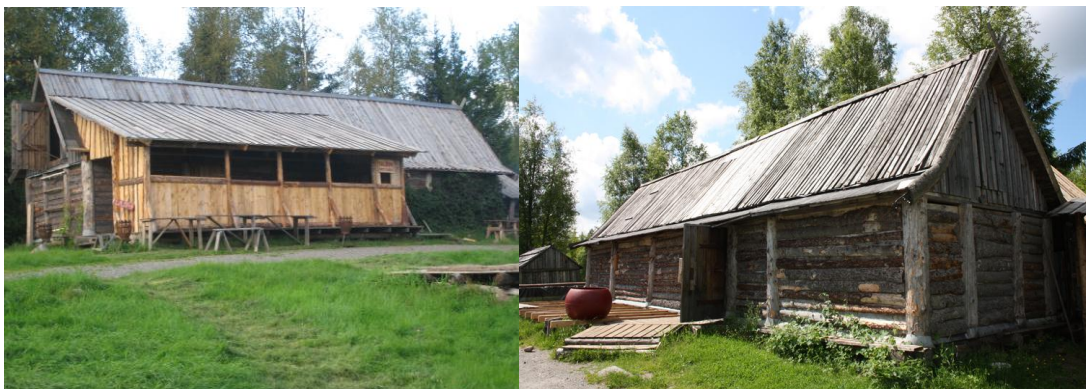
Figur 6: Värdshus i verksamhetsklass 2A. Vänstra bilden är tagen efter utbyggnad (Berghem, 2012)
