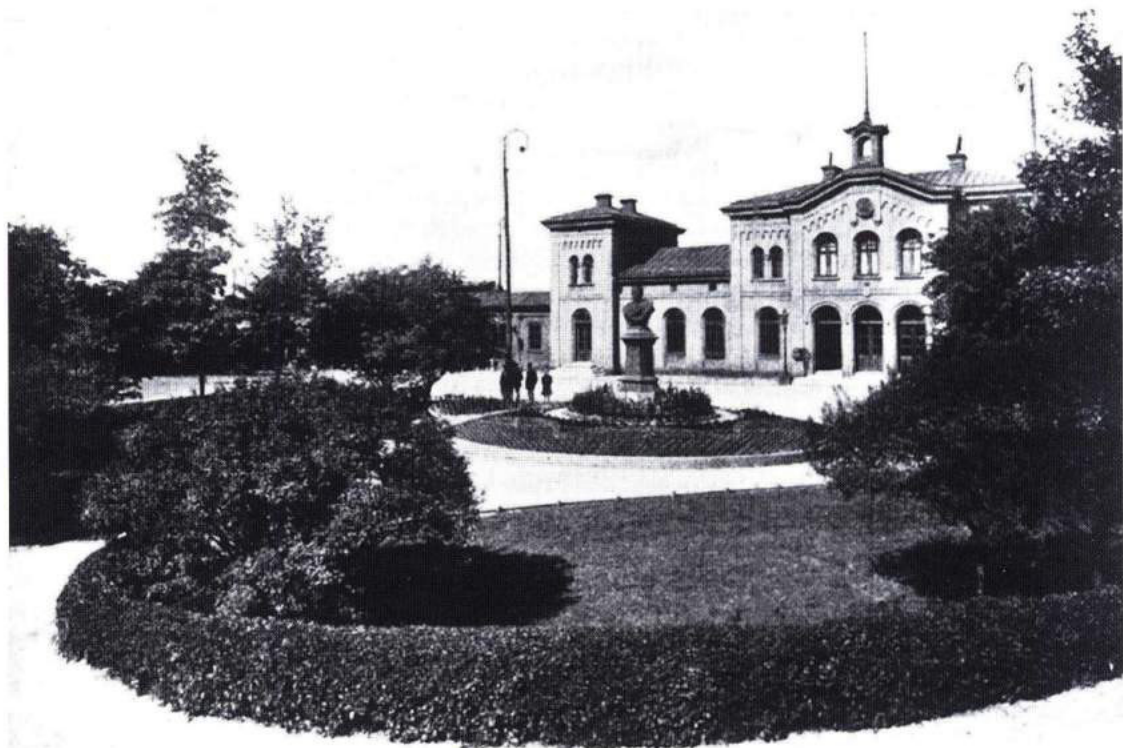
Figur 3. Äldre typ av stationsanläggning. Örebro från stadssidan. (Ur: Statens järnvägar 1856-1906 ).
