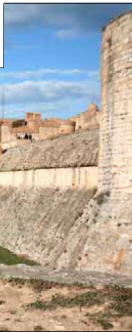
14b Salses kapuvédelmi rendszere és árka a várarók külső partjáról. Az egész erődítményt a tűzéréség elleni harcra tervezték: mélyen az árokba súlylyesztették, a védműveket viszonylag alacsonyra építették és mindenütt íves felületeket alakítottak ki
