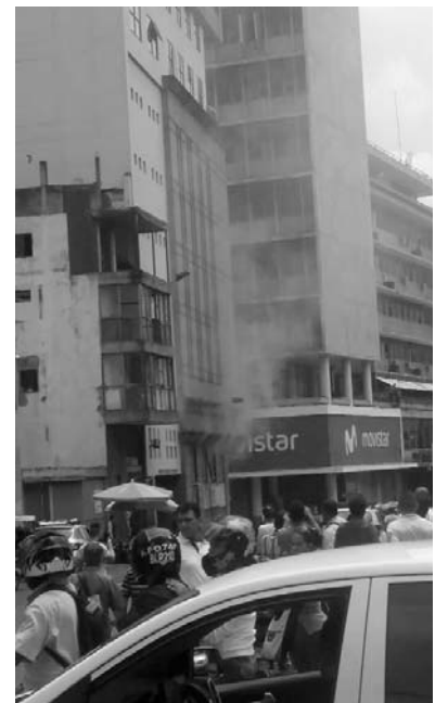
Los Bomberos de Cali lograron contener las llamas en la edificación.
