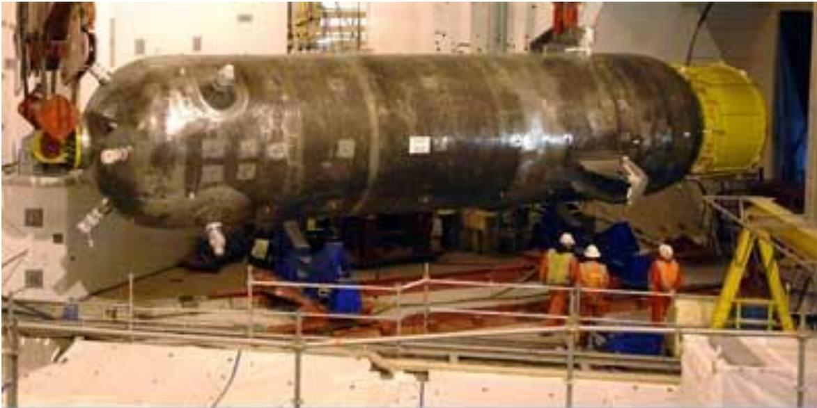
**FIGURA 18. MANTENIMIENTO SOBRE UN PRESIONADOR**
