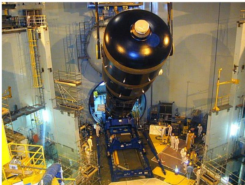
FIGURA 21. INSTALACIÓN DE UN GENERADOR DE VAPOR DENTRO EL RECINTO DEL REACTOR
