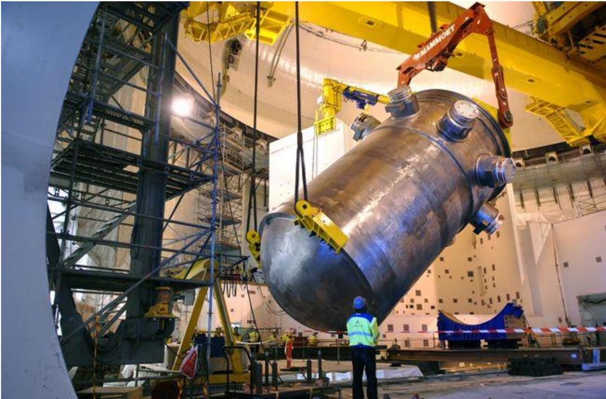
FIGURA 9. INSTALACIÓN DE LA VASIJAS DENTRO EL RECINTO DEL REACTOR
