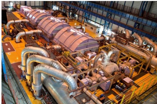
FIGURA 23. LA TURBINA BAJA-PRESIÓN Y LAS 3 ALTA-PRESIÓN
