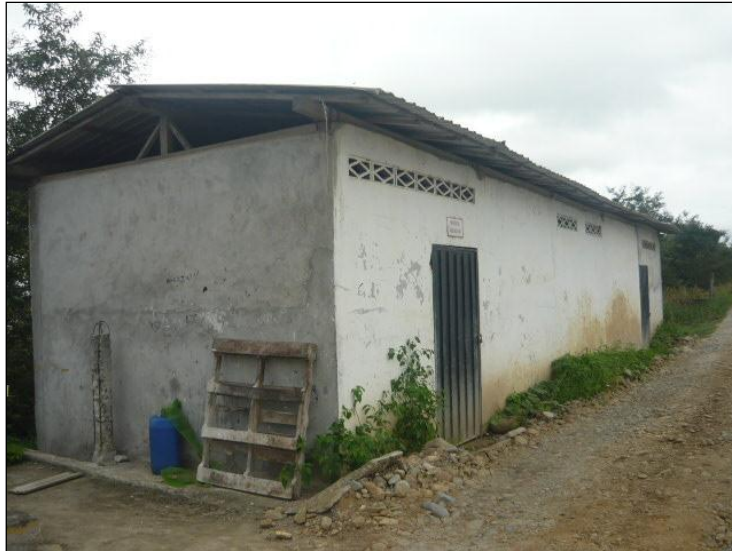
Foto 6 Vista del bloque utilizado como bodega de balanceado y de cal.
