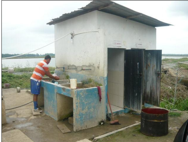
Foto 5 Vista de la Batería Sanitaria para el personal de campo en el campamento de la camaronera Mar de Oro
