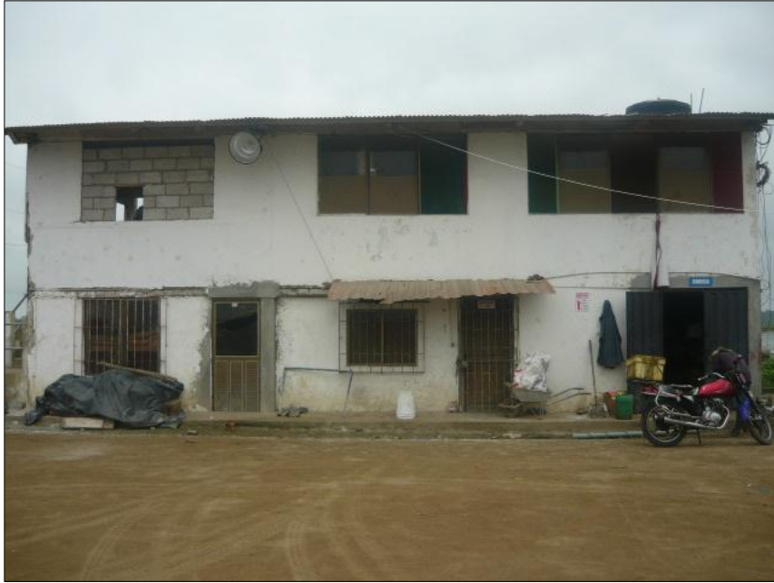
Foto 1 Vista de la fachada de la casa principal en el campamento de la camaronera Mar de Oro
