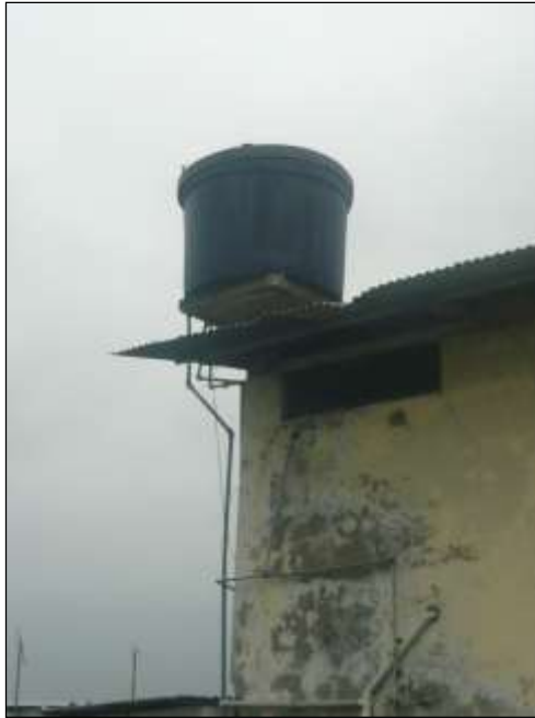
Foto 8 Vista del tanque elevado para almacenar 500 litros de agua para consumo doméstico.
