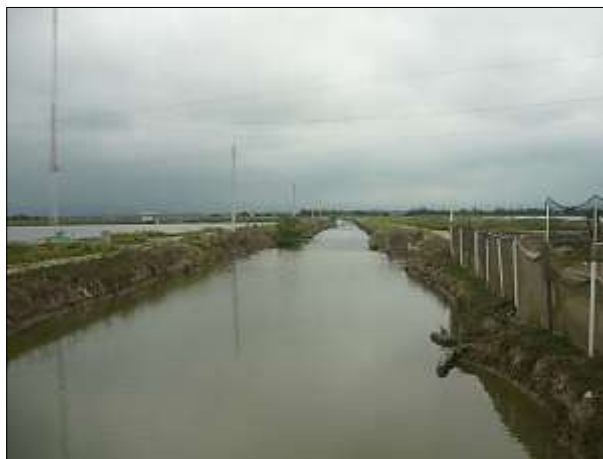
Foto 15 Vista del canal reservorio en MardeOro
