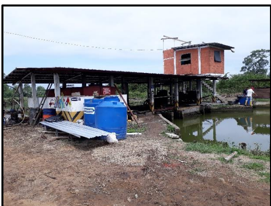
Área de Combustible
