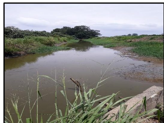
Canal de entrada
