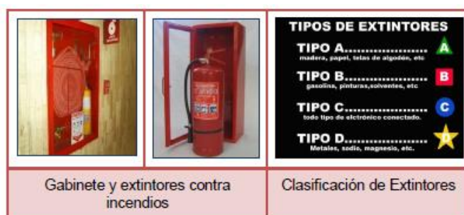
Figura 20. Equipo contra incendio y tipo de extintores
