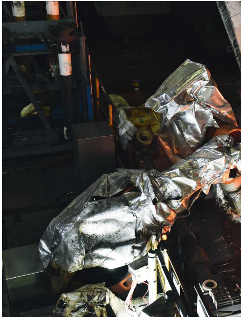
图3： LiquiRob机器人系统全自动执行钢包长水口操作。
