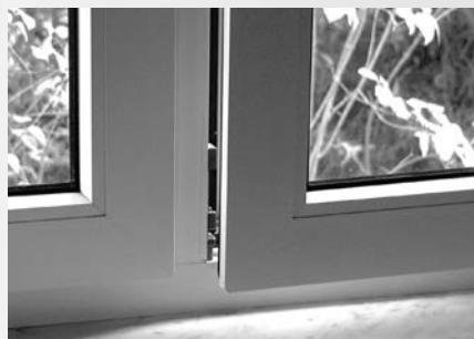
Nicht sichtbarer Magnet in Kunststofffensterrahmen für Alarmanlagen
