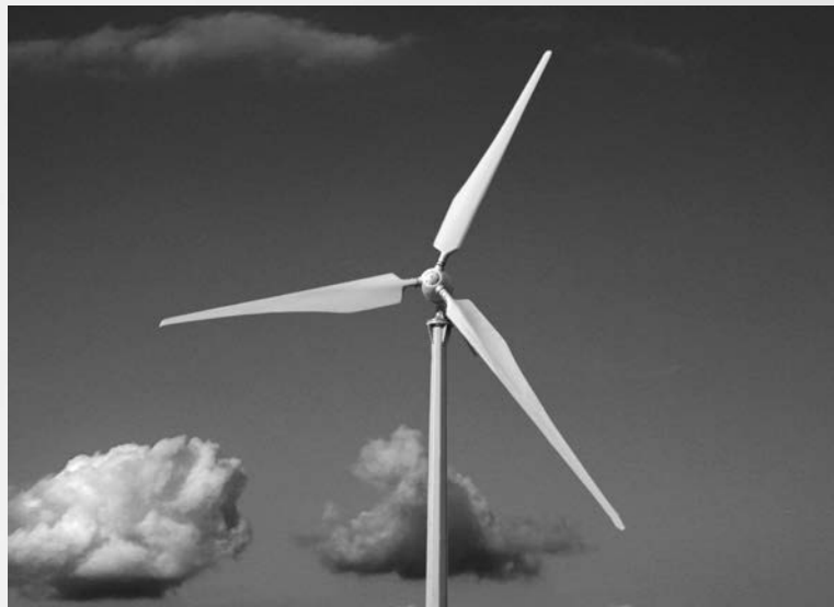
Windkraftwerk mit permanentmagneterregtem Generator
