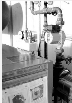
Heizungsgehäuse mit Magnetverschluss
