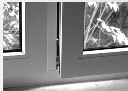
Nicht sichtbarer Magnet in Kunststofffensterrahmen für Alarmanlagen
