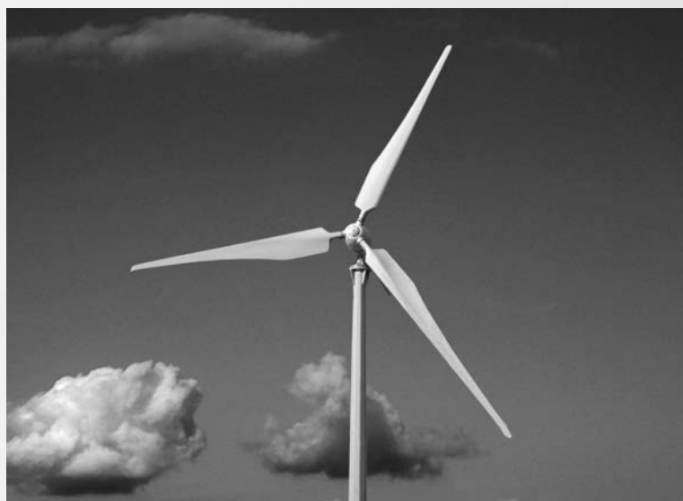
Windkraftwerk mit permanentmagneterregtem Generator
