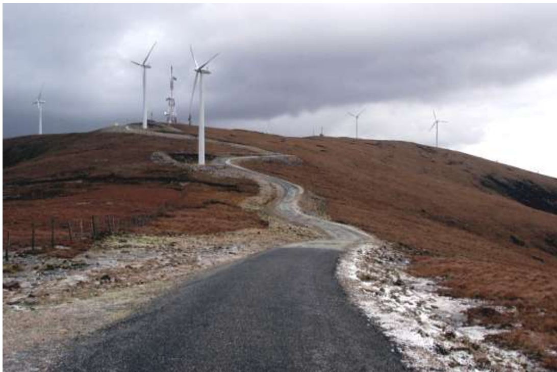
Turbeiras de cobertor activas afectadas polo sistema de vias dun parque eólico (Serra do Xistral, Lugo).
