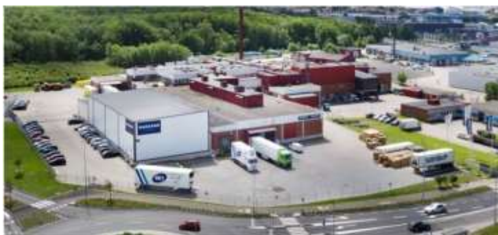
Anläggningen i Varberg
